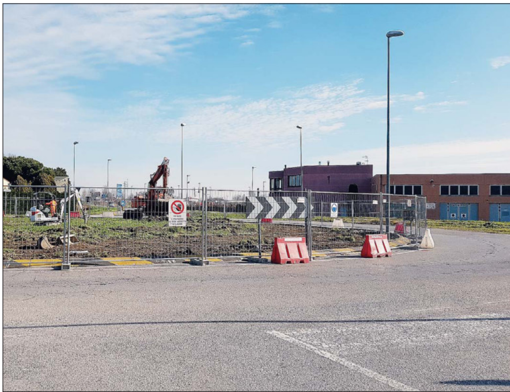
I lavori in corso sulla rotatoria di via Chieppara
