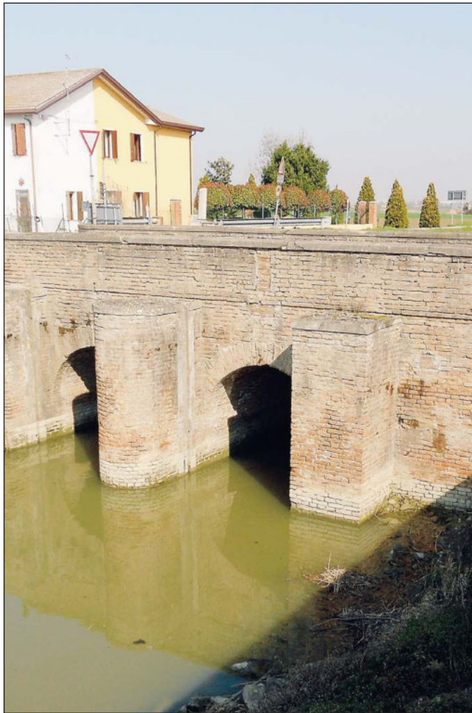
Il ponte romano sullo scolo Bellombra
