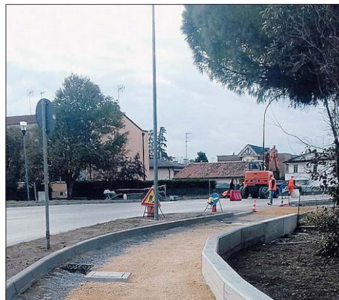
Via Regina Margherita | lavori per realizzare la ciclopedonale
