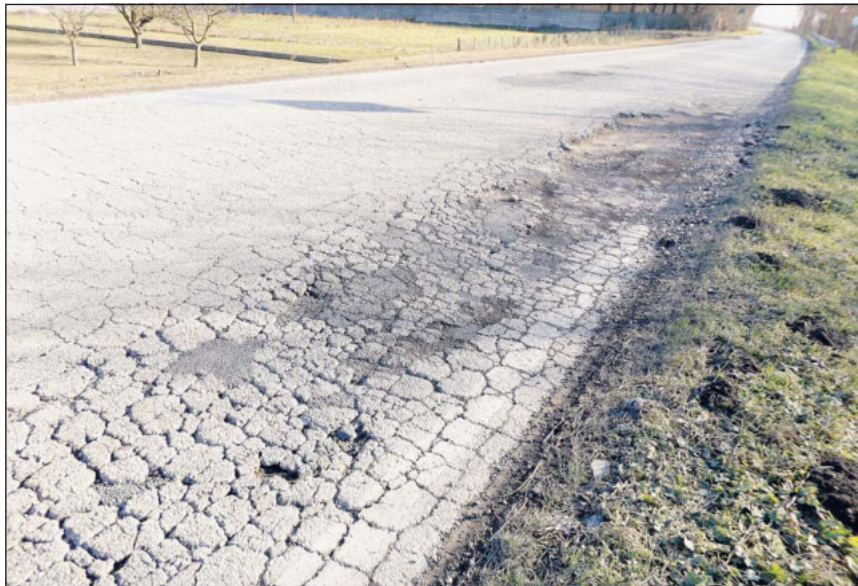
Strada provinciale Le condizioni pietose in cui versa la strada, aggravate dalle recenti ghiacciate notturne che hanno rovinato ulteriormente l'asfalto
