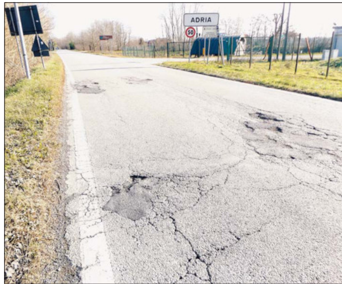
Strada provinciale Le condizioni pietose in cui versa la strada, aggravate dalle recenti ghiacciate notturne che hanno rovinato ulteriormente l'asfalto
