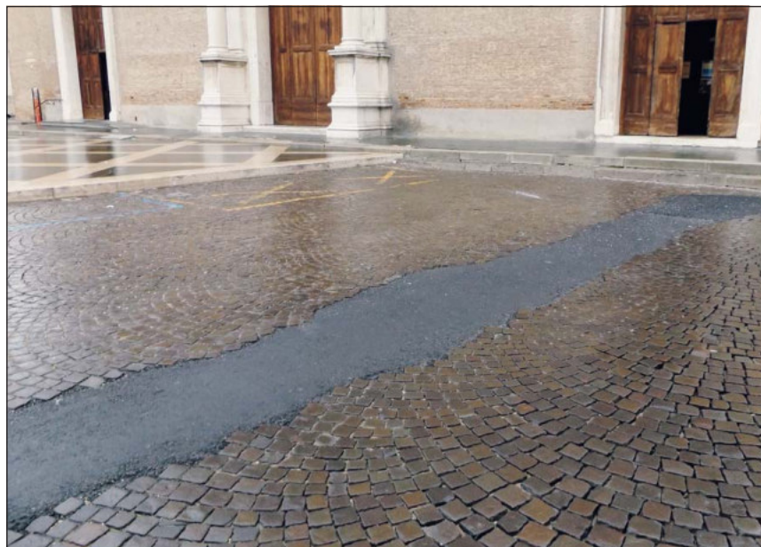
Nelle foto, la piazza, sul lato est, attraversata in tutta la sua lunghezza da una pezza di asfalto su un lastricato di porfido
