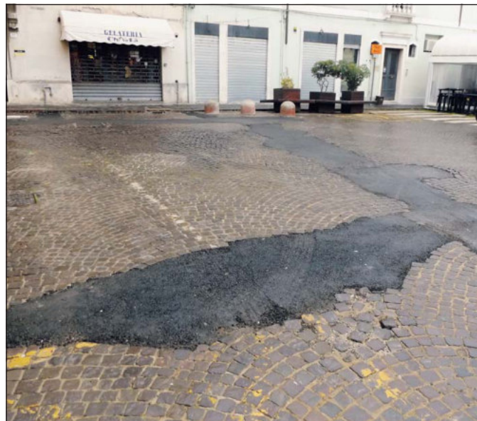
Nelle foto, la piazza, sul lato est, attraversata in tutta la sua lunghezza da una pezza di asfalto su un lastricato di porfido
