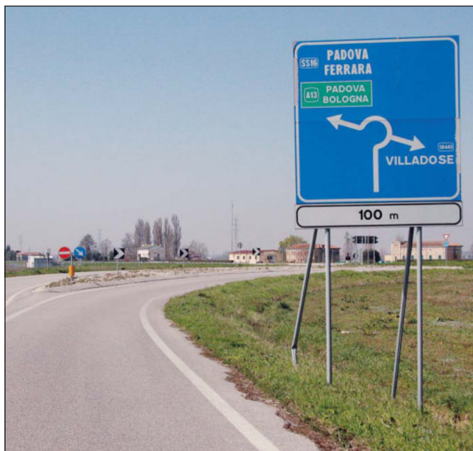
Si avvicina il completamento del Passante Nord
