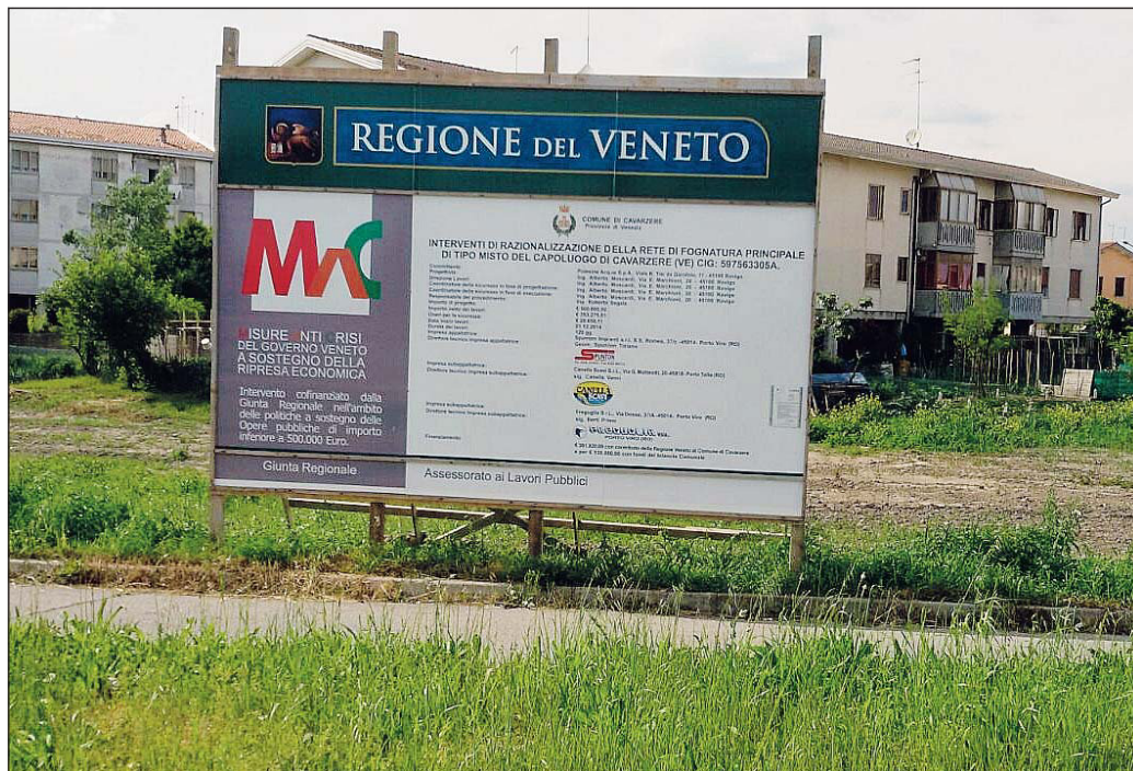
I lavori in via Mazzini per la regimazione delle acque
