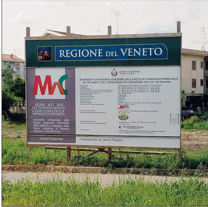
I lavori di via Mazzini commissionati da Polesine Acque ma pagati da regione Veneto e comune di Cavarzere
