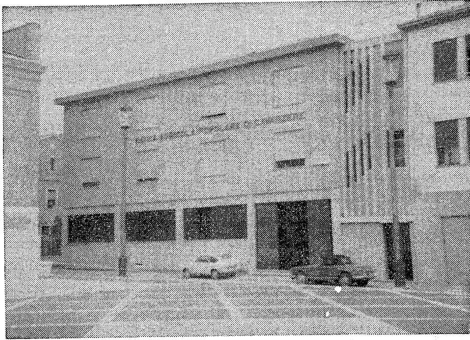
La centrale piazza del Duomo di Cavarzere si è abbellita con la costruzione della nuova sede dell'Istituto di credito cittadino, aperta recentemente.
