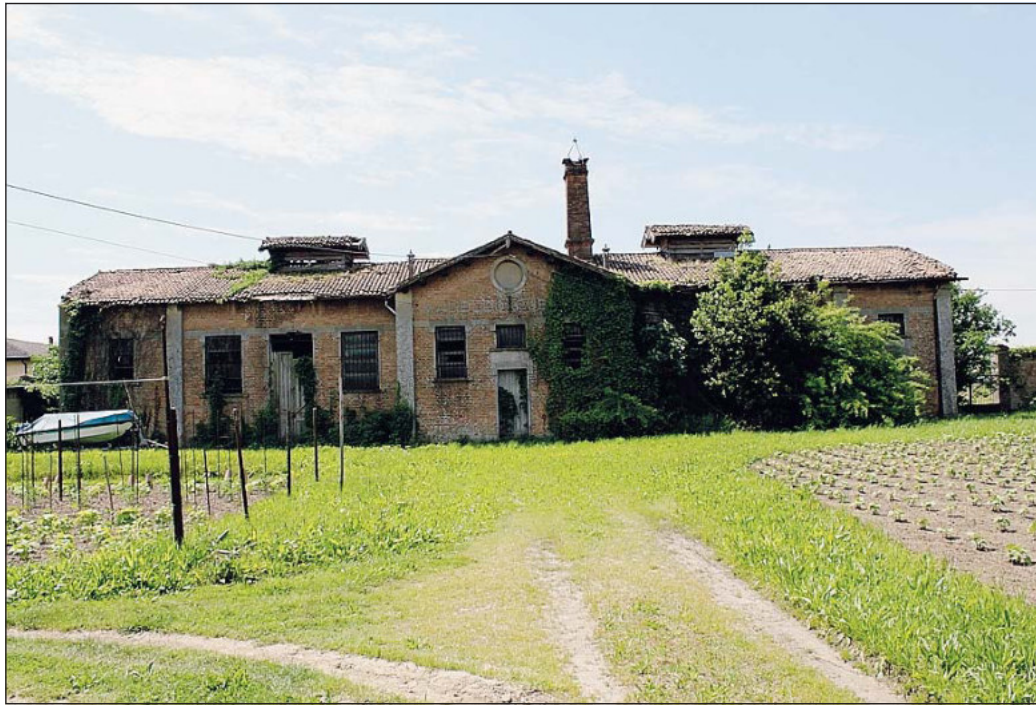
L'ex Macello ed ex Monta equina Il comune cerca idee e progetti per procedere al restauro
